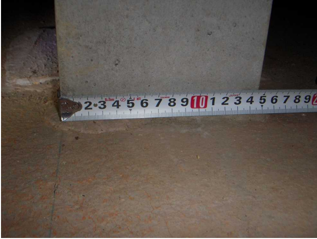
【基礎幅】 基礎幅は150mmで図面通りの寸法でした。
