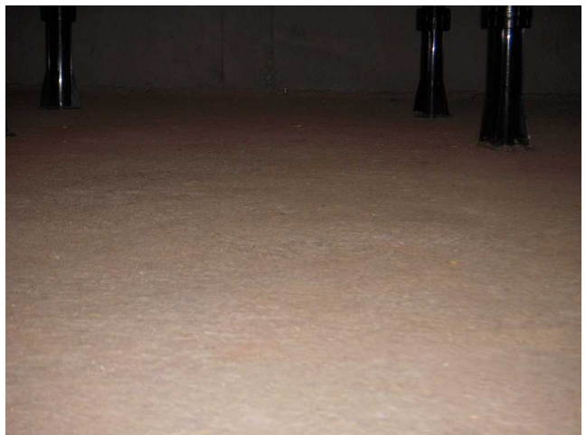
【床下の状況】 床下は丁寧に清掃されており、木くずやゴミの散乱はありません。
