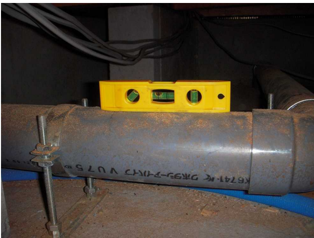
【配水管】 浴室やキッチンなどの排水管の状態です。水漏れ等もなく、また、排水勾配も適切に確保されていました。
