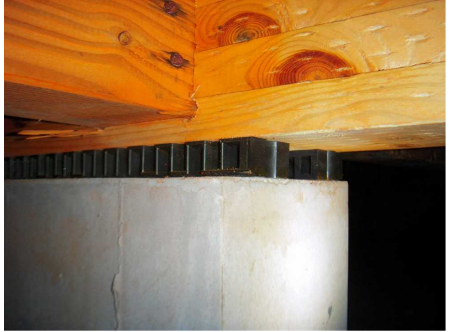
【基礎パッキン】 床下の換気を確保するための基礎パッキンです。全周に設置するタイプですので入れ忘れがありません。丁寧に施工されていました。
